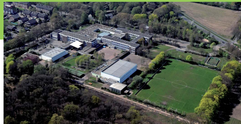
Luftbild Schulzentrum Rhede;
