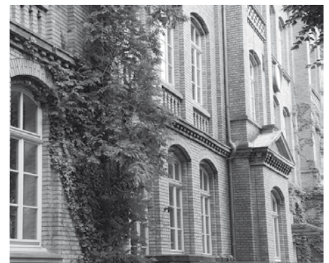
IGS Kastellstraße – Fassade
